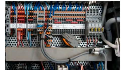
Der Schaltschrank des Seilzuges ist konsequent modular aufgebaut: sämtliche Bauteile sind steckbar und können bei Bedarf am freien Markt aus der Produktion namhafter Hersteller nachgekauft werden – ein großer Servicevorteil!
